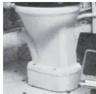
socle en maçonnerie
